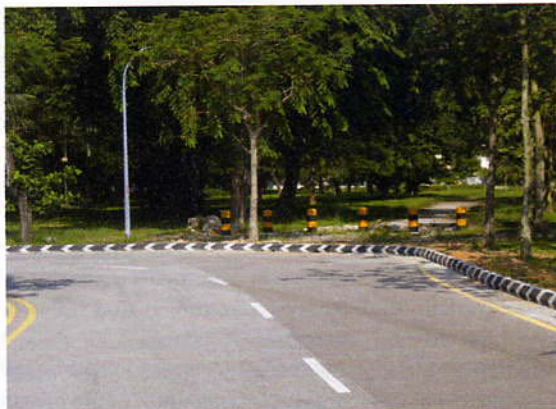
Fig. 2 Curve using reflective curbs. Abb. 2 Eine Kurve, für die reflektierende Bordsteine eingesetzt wurden.
